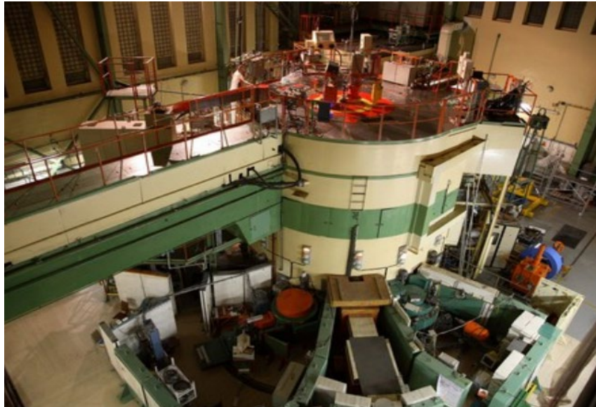
Obr. 7 Pohled na výzkumný jaderný reaktor LVR-15 v Centre výzkumu v Řeži. Na jeho snímku jsou rozeznatelné jednotlivé kanály.
